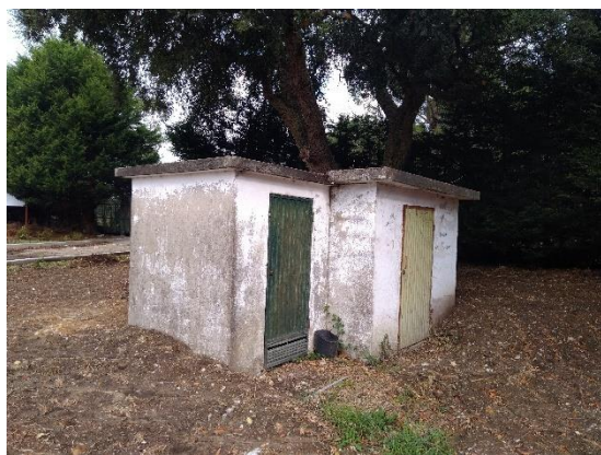
Figura 2.3 – Captação subterrânea (furo) que abastece toda a instalação.
