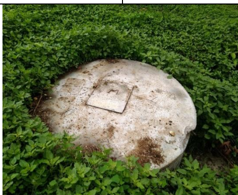
Figura 3.5 – Fossa central estanque da instalação.
