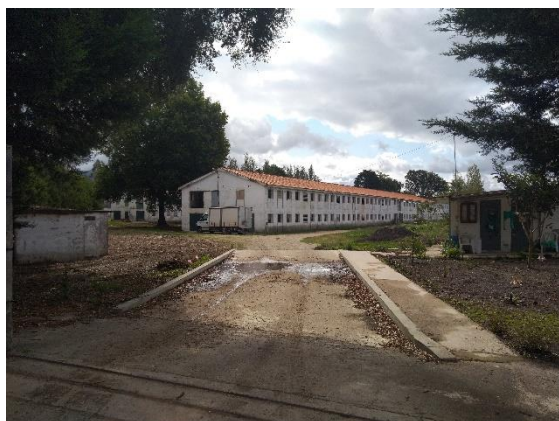
Figura 2.1 – Vista do exterior do pavilhão de recria e rodiluvio à entrada da instalação.
