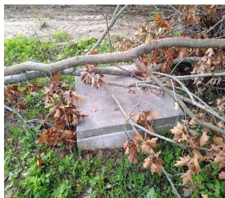
Figura 3.4 – Caixa de receção dos chorumes provenientes do Pavilhão C.
